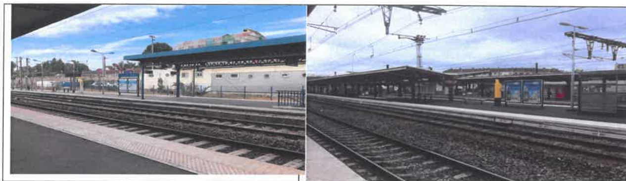
Exemples de dispositifs doubles sur quais de gare (hors territoire)
